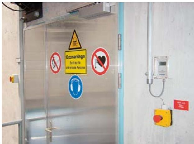
**Figura 2** Pulsante di arresto d'emergenza fuori dal locale di installazione del generatore di ozono
