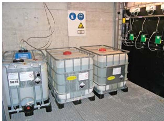
**Figura 3** Vista del locale separato per il dosaggio di acido. Il pavimento è strutturato come una vasca di raccolta; nell'angolo, canale di scarico per la ventilazione artificiale del locale.
