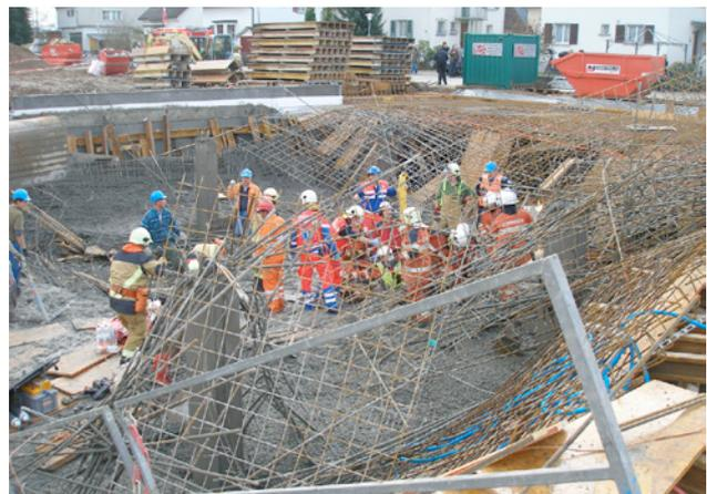
6 La casseratura di soletta è crollata insieme al ferro d'armatura per l'azione di forze eccentriche.
