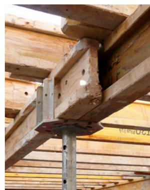
1, 2 Giunzione scorretta tra le travi longitudinali (a sinistra): scarsa stabilità a causa di forze eccentriche. È necessaria una testa a forcina (a destra).
