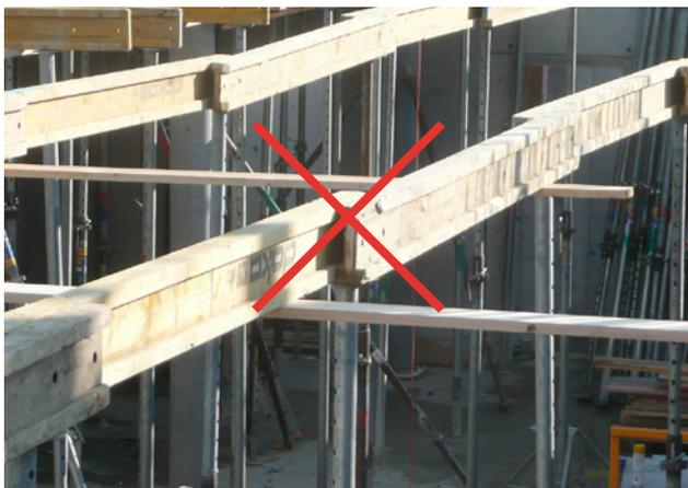
5 Supporti per elementi prefabbricati in calcestruzzo: scarsa stabilizzazione, puntelli non verticali, assenza delle teste a forcetta
