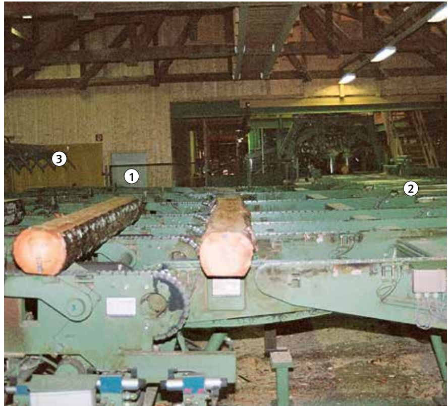
Bild 25: Querförderanlage zum Zuführbereich der Nachschnittsäge (aus dem Innenbereich der Umzäunung fotografiert)
