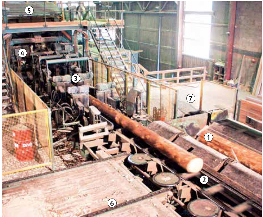
Bild 21: Anlagenbereich Blockzug, Einzugs- und Zentriereinrichtung, Parallelzerspaner, Reduzierbandsägen. In diesem Beispiel wurde zwischen Rundholz-Zubringung und Reduzierbandsägen keine weitere Gefahrenbereichsunterteilung vorgenommen.
