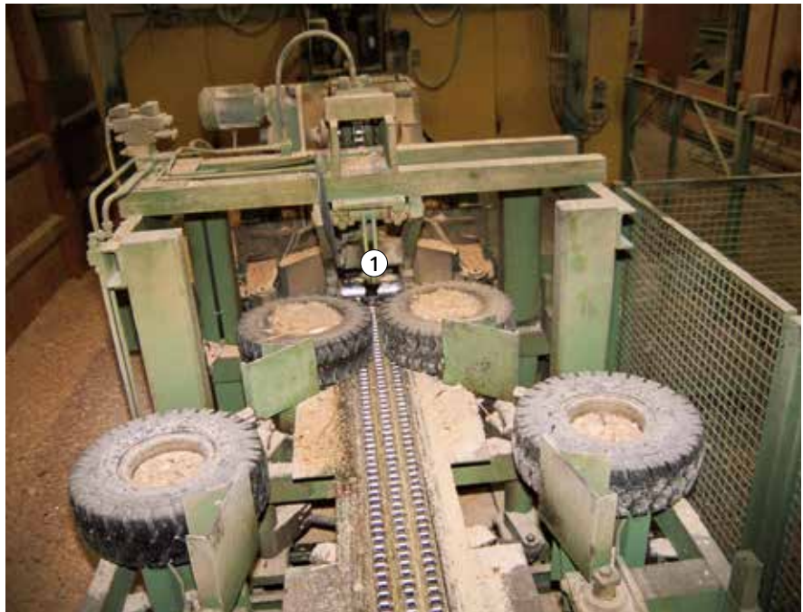
Bild 24: Geschlossenes Einzugswerk als Schutz gegen Herausschleudern von Werkstücken und Werkstückteilen
