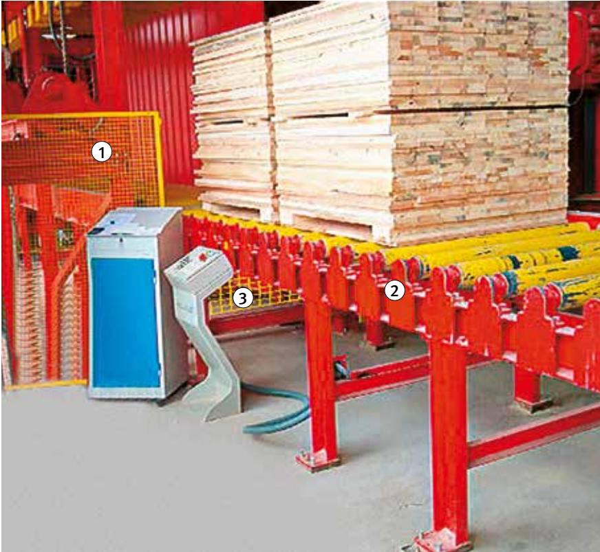
Bild 36: Ausführungsbeispiel Rollengang als Teil der Zugangssicherung zum Gefahrenbereich einer Stapelanlage
