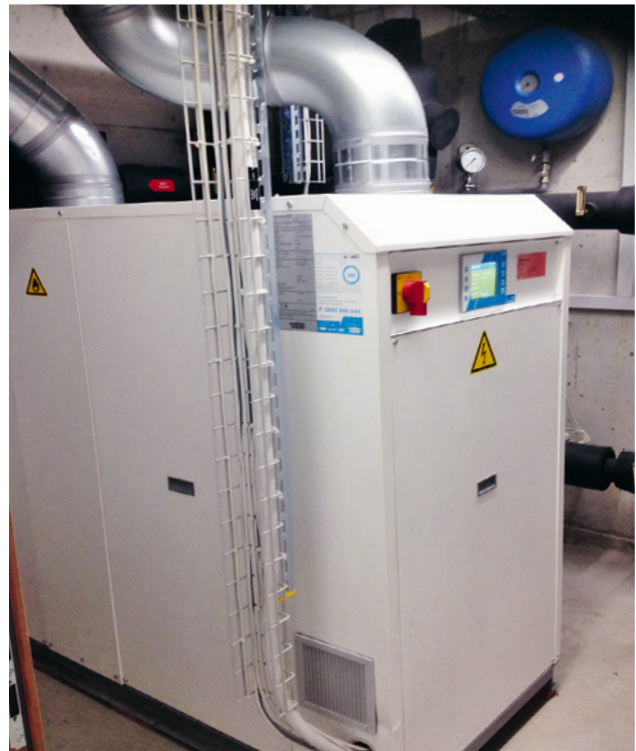
Kälteanlage in belüftetem Gehäuse.
