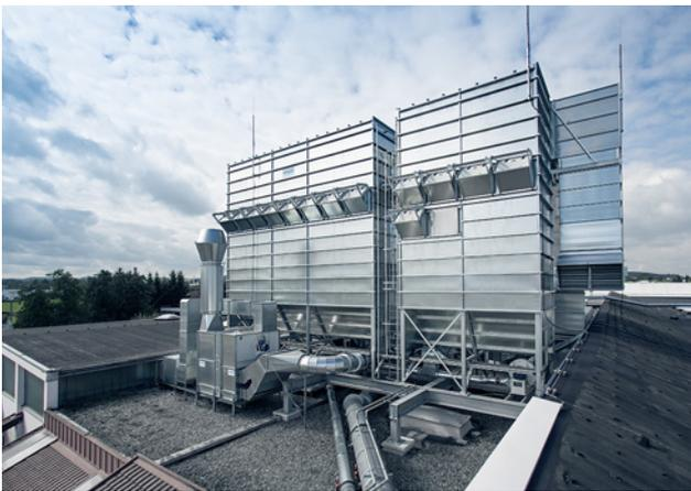
11 Sistema di filtrazione installato all'aperto (fonte: Scheuch LIGNO GmbH)
