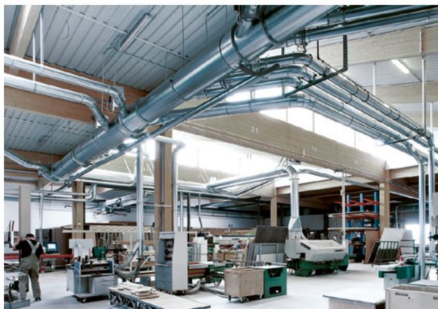
16 Condotti tra macchine per la lavorazione del legno, sistema di estrazione e silo (fonte: Scheuch LIGNO GmbH)
