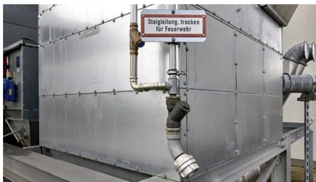
2 Condotta di soppressione dell'incendio con un accoppiamento Storz per tubo flessibile antincendio (fonte: Türenfabrik Brunegg AG).
