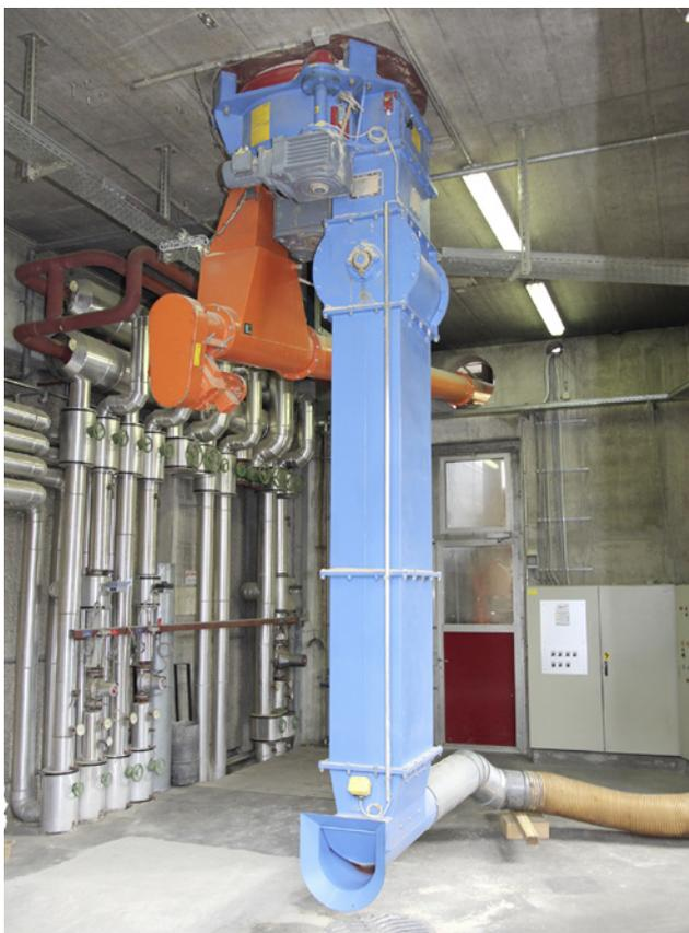
23 Estrazione di trucioli di legno con aspiratore; in esercizio normale tramite il secondo pozzetto a caduta (blu) – (fonte: Toma Holz AG)
