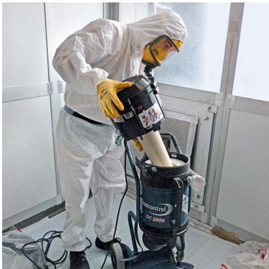
Lavori all'interno di una zona da bonificare. // Suva
