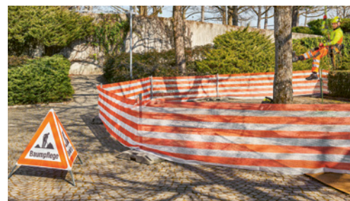
1 La zona di pericolo è segnalata e interdetta a terzi.
