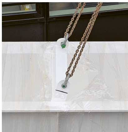
1 Mettre en œuvre les points d'ancrage aux endroits définis au préalable.
