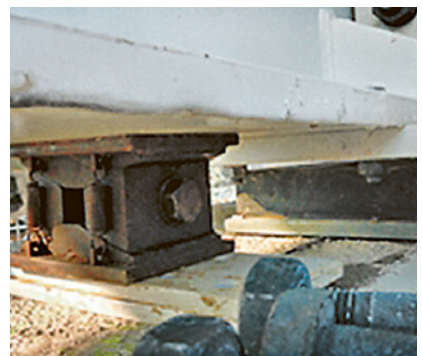
3 Prudence lors de l'utilisation d'appuis temporaires: prévenir tout risque de renversement des éléments!
