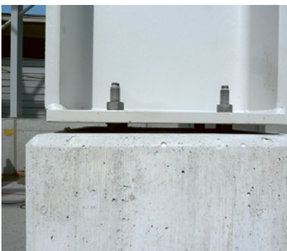
1 Platine de base correctement sécurisée avec quatre ancrages
