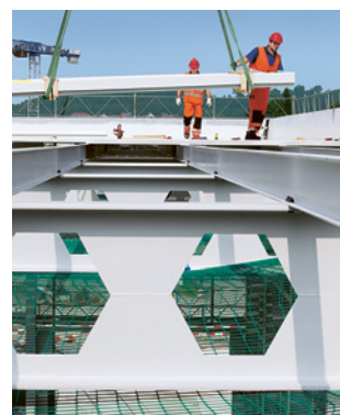
Règle 8 Installer des protections collectives.
