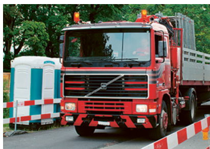
1 Séparer les voies de circulation des personnes de celles des véhicules.
