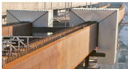
2 Enceinte confinée de soudage: accès et postes de travail sûrs
