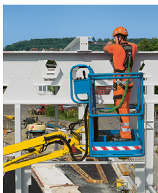
Règle 6 Utiliser des équipements de travail appropriés.
