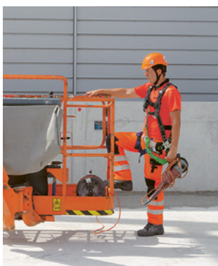
Règle 5 Porter les équipements de protection individuelle (EPI).
