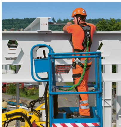
2 Montage à l'aide d'une PEMP
