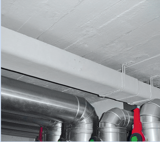
Kabelkanal aus Asbestzement
