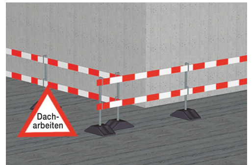
5 Abschränken des Gefahrenbereichs
