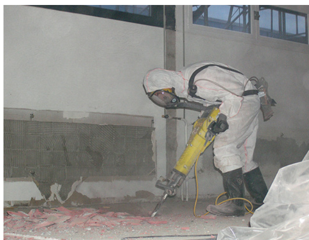
2 Enlèvement d'un revêtement de sol à l'aide d'un marteau piqueur
