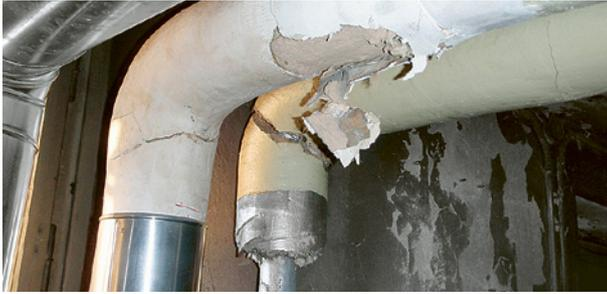
Tuyau avec mortier amianté
