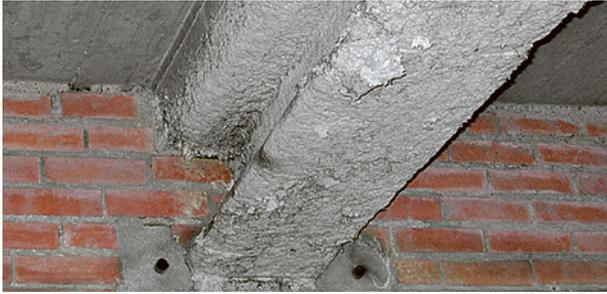
Amiante floqué sur poutre métallique
