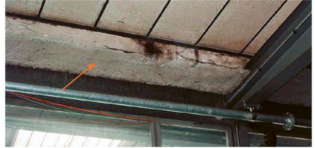
Isolation en amiante floqué sur un toit
