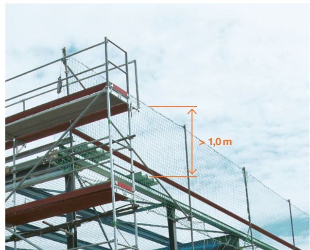
1 Bord supérieur du filet composé d'un câble métallique précontraint: il faut empêcher toute chute verticale entre le filet et la façade. Le bord supérieur du filet se situe à 1,0 m au-dessus du niveau fini de l'ouvrage.
