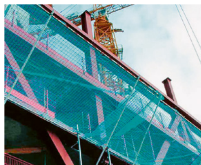
5 à 7 En Suisse, du fait des échafaudages obligatoires (art.26 OTConst), les éventails antichute sont rarement utilisés.
