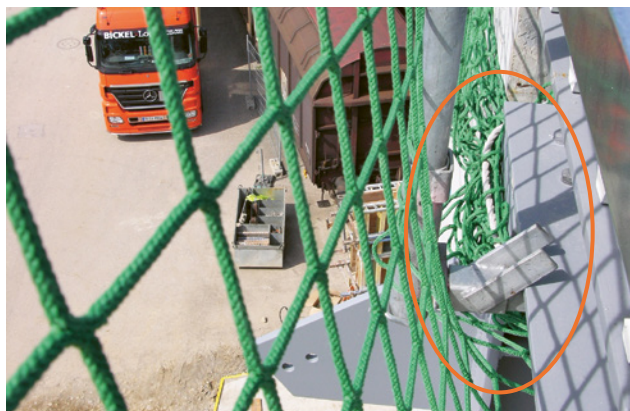
3 Le filet du garde-corps périphérique doit être fixé de façon à ne pas former d'ouverture de plus de 30 cm en cas de charge.
