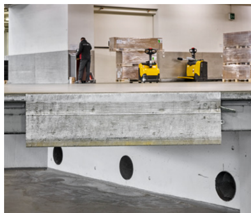
6 Auf einer Führungsschiene befestigte Überladebrücke
