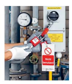
**Arbeitnehmer:** Bevor ich an der Anlage arbeite, schalte ich alle Energiequellen und Materialströme aus. Ich sichere die Abschalteinrichtung mit meinem persönlichen Vorhängeschloss.
