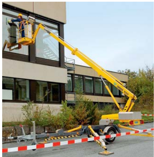
19 Fensterreinigung mit Hilfe einer Arbeitshebebühne.
