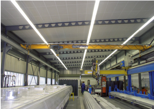
80 Soffitto fonoassorbente in un locale dove si effettua la saldatura di alluminio
