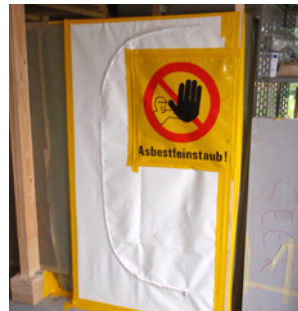
4 La zone d'assainissement est clairement signalée et délimitée.
