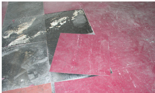
1 Dans les revêtements floor flex monocouches (durs et cassants), les fibres d'amiantes sont intimement liées à la matrice.
