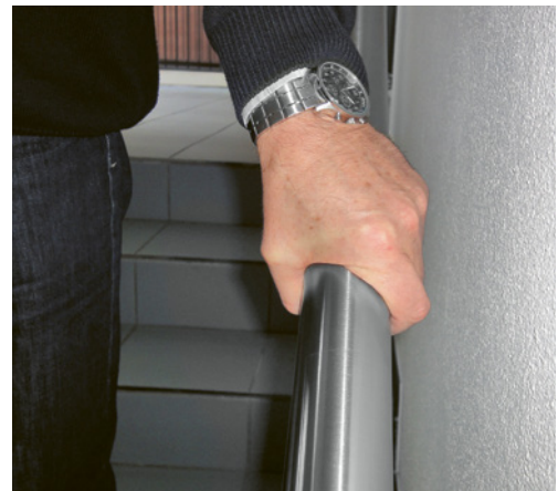
2 Angenehmer Handlauf von 40 mm Durchmesser
