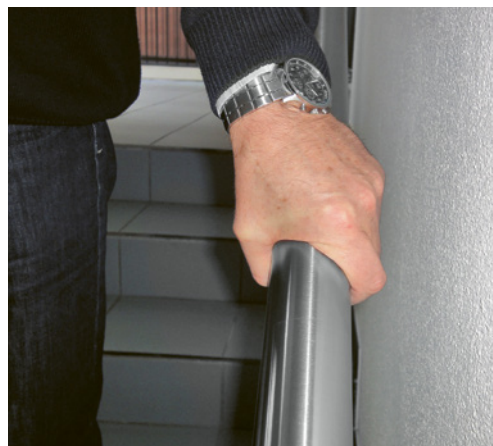
2 Angenehmer Handlauf von 40 mm Durchmesser
