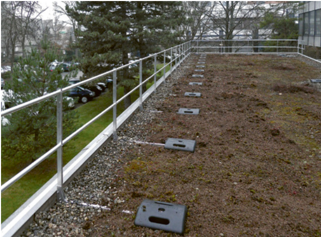
1 Kollektivschutz bietet optimale Sicherheit am Dachrand
