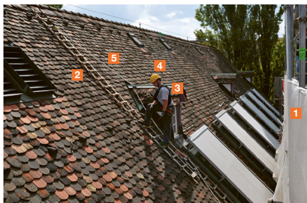
12 Arbeitsplatz-Positionierungssystem auf einem geneigten Dach
