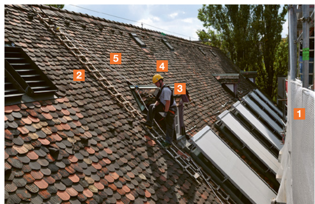
12 Arbeitsplatz-Positionierungssystem auf einem geneigten Dach
