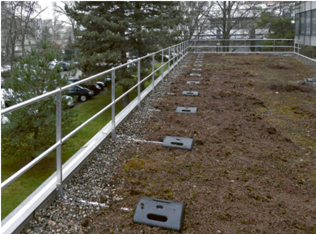
1 Kollektivschutz bietet optimale Sicherheit am Dachrand
