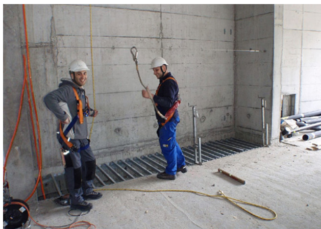
3 Einbau der flächigen Abdeckung mit PSA gegen Absturz
