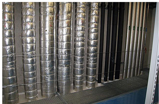
1 Durchbruchssichere Brandabschottung. Gitterrost über der Brandabschottung
