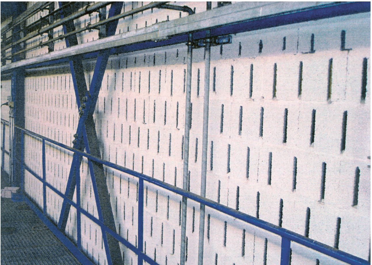
19 Pierres spéciales fissurées avec vides et éléments amortisseurs dans un atelier de serrurerie.
