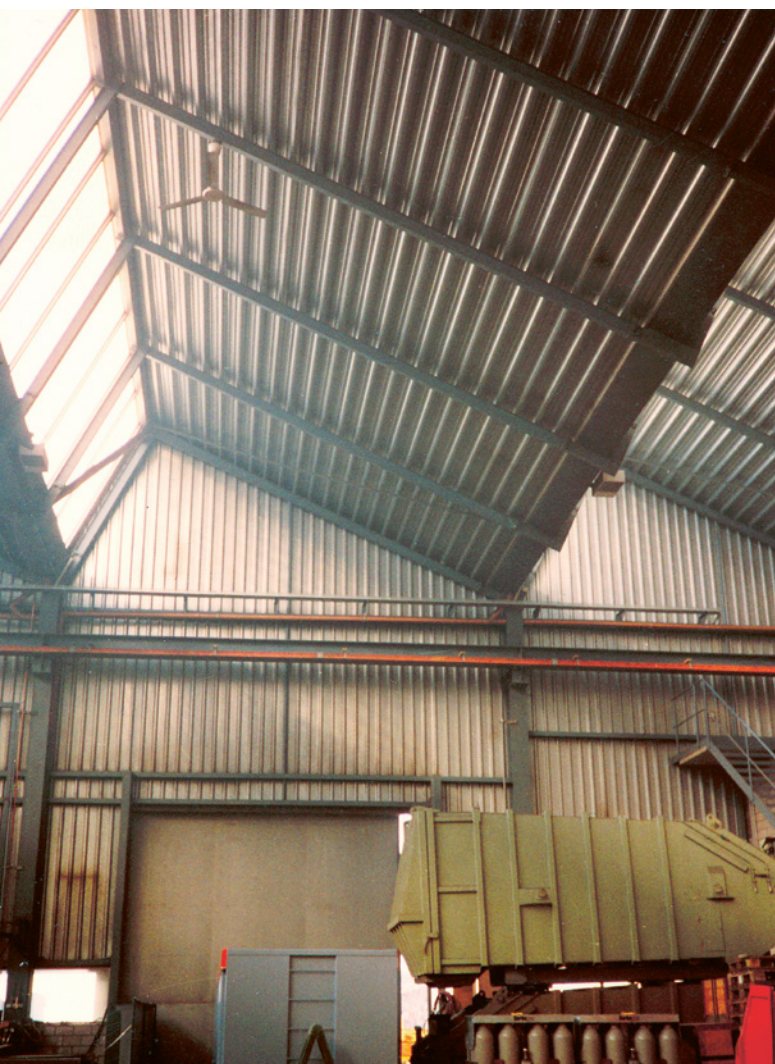
1 Exemple typique d'un atelier de fabrication sans correction acoustique (local très réverbérant).
