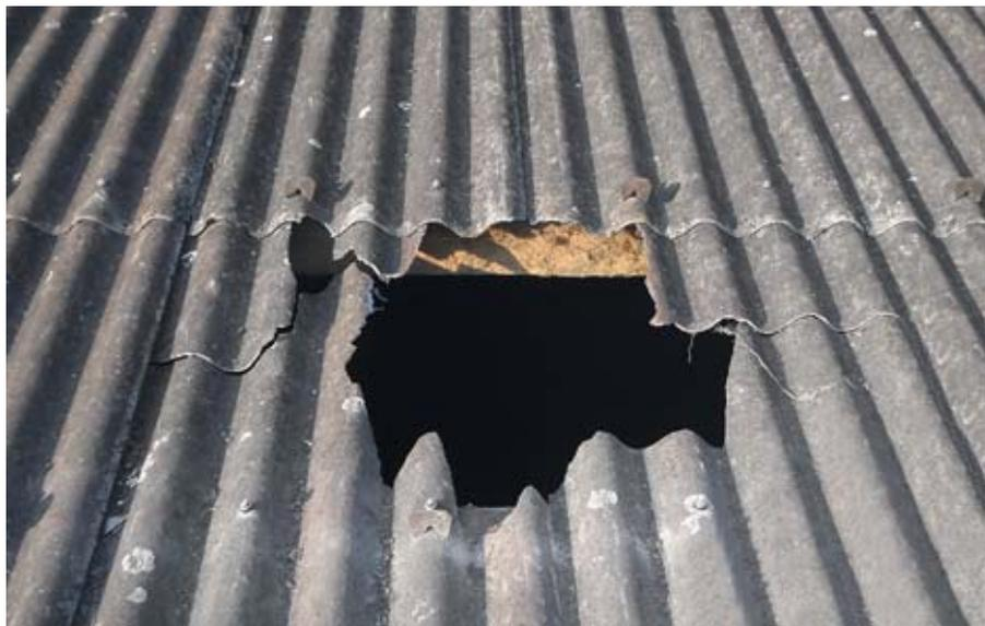
01 // Durch dieses Faserzementdach stürzte der temporäre Mitarbeiter ab. Er erlitt schwerste Verletzungen. // Suva
