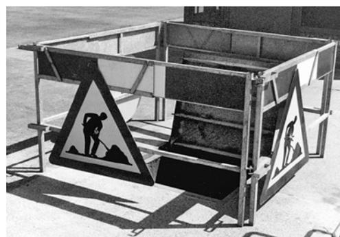
5 Clôture autour de l'ouverture d'une fosse. Les dangers découlant de l'exécution de travaux prévus chez le client doivent être limités en collaboration avec le client.
