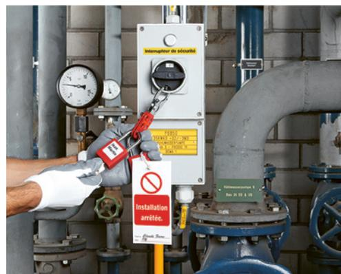
4 Interrupteur de sécurité en position 0 avec cadenas individuel permettant d'éviter un réenclenchement inopiné.
