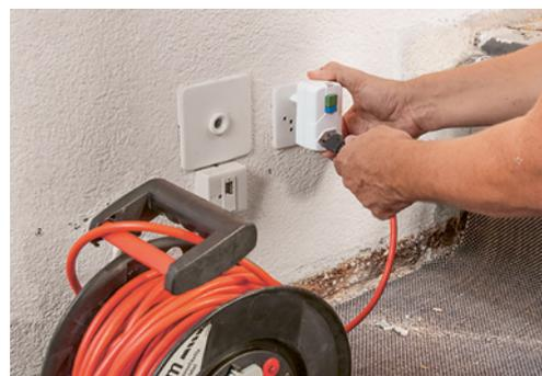
6 Lorsqu'il n'y a pas de tableaux de distribution de chantier à disposition, il faut utiliser des prises différentielles mobiles (DDR).
