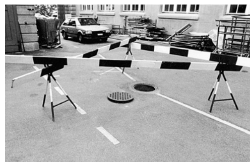
9 Sbarramento di un posto di riparazione temporaneo
