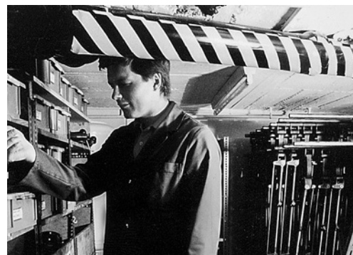
5 Rivestimento in gomma piuma a strisce giallo/nero, applicato a un tubo vicino a scaffali
