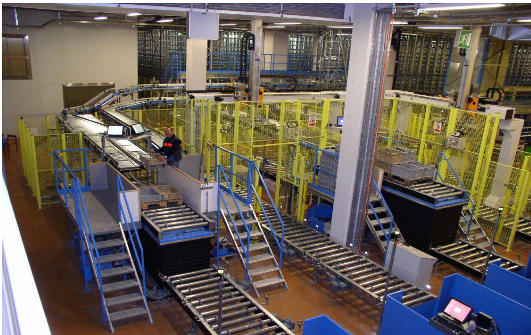
Figura 3: stesso impianto della figura 1, qui prima della messa in funzione.
