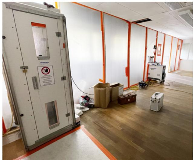
1 Umbau: Zone mit UHG (Unterdruckhaltungsgerät) und Schleuse
