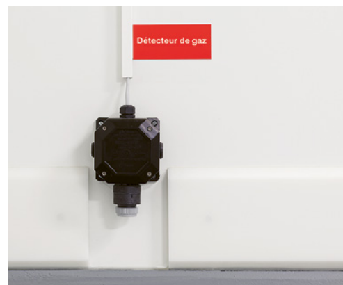
7 Système de détection des gaz
