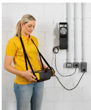
Règle 5 Contrôler l'installation avant la mise en service.
