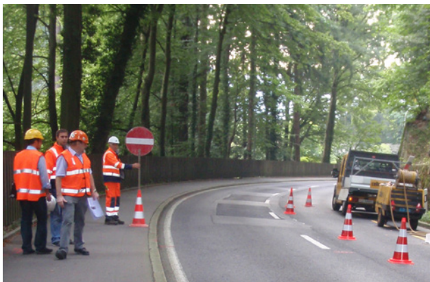
2 Le port de vêtements de signalisation à haute visibilité de classe 2 (torse couvert) est également nécessaire en cas de séjour de moins d'une heure sur la voie publique (p. ex. pour un contrôle de chantier, une visite des lieux).
