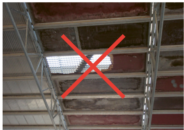
Fig. 1 De grosses taches noires indiquent un début de pourriture. Le platelage doit être contrôlé.
