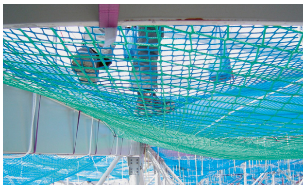
2 Flèche du filet plateforme < 50 cm.
