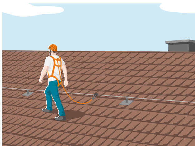
15 Protection contre les chutes installée à demeure (câble en fils métalliques)
