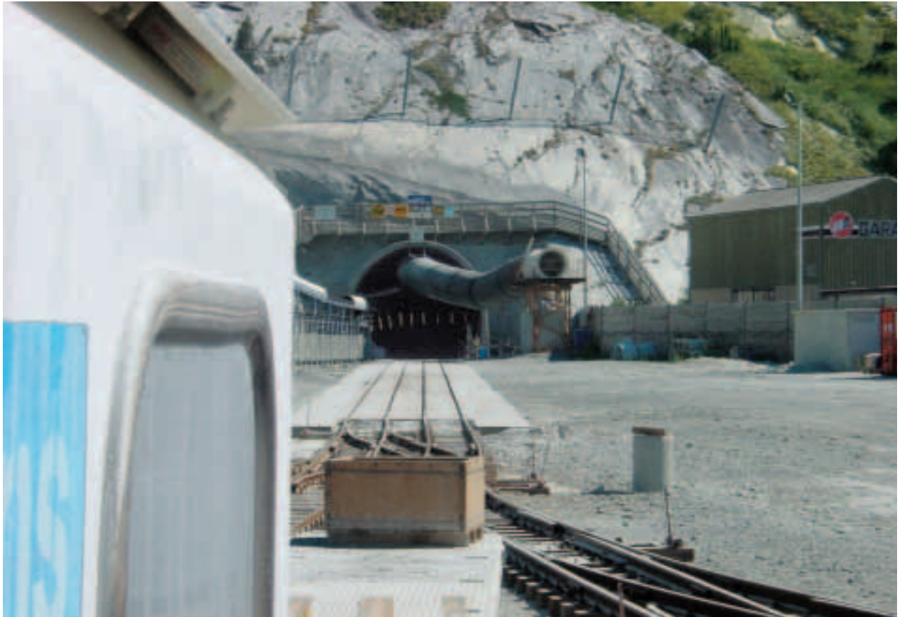
Abbildung 1 Einfahrt mit der Stollenlokomotive in den Stollen bei Raron.
