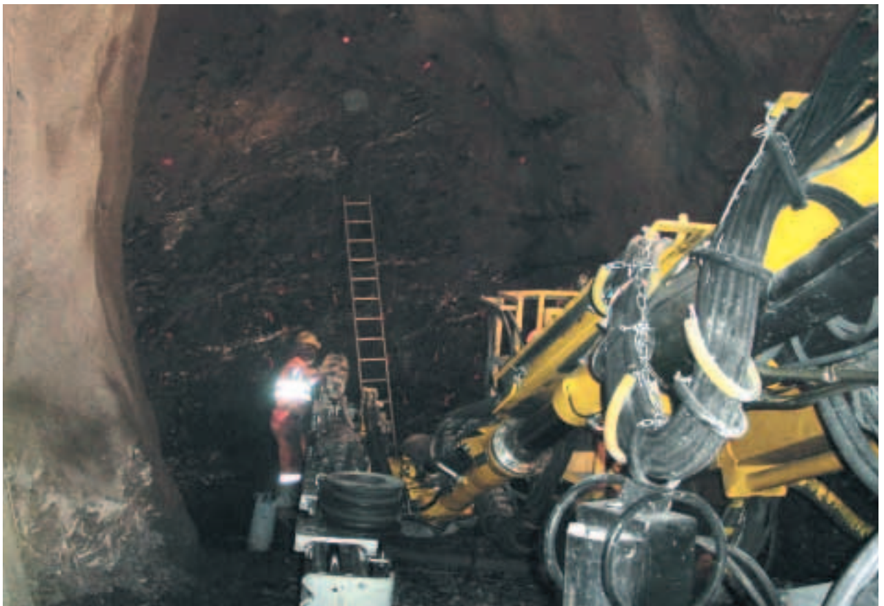
Abbildung 6 Laden der Tunnelbrust eines Seitenstollens mit dem «Jumbo».
