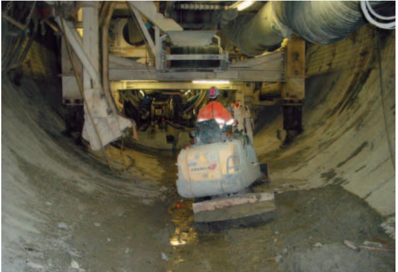
Abbildung 5 Arbeiten im Vortriebsbereich unterhalb der Tunnelbohrmaschine.
