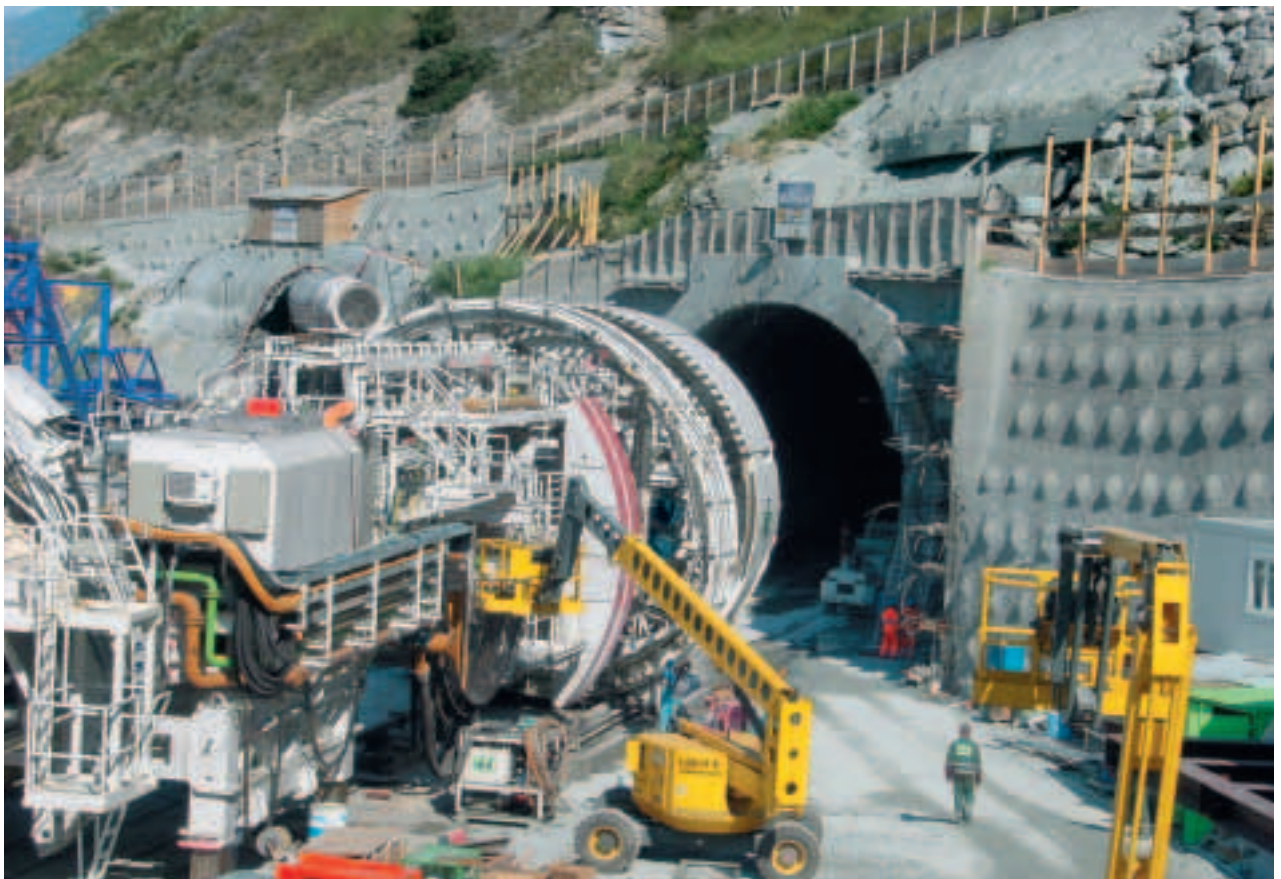
Abbildung 2 Kopf der Tunnelbohrmaschine vor der Einfahrt in den Stollen.
