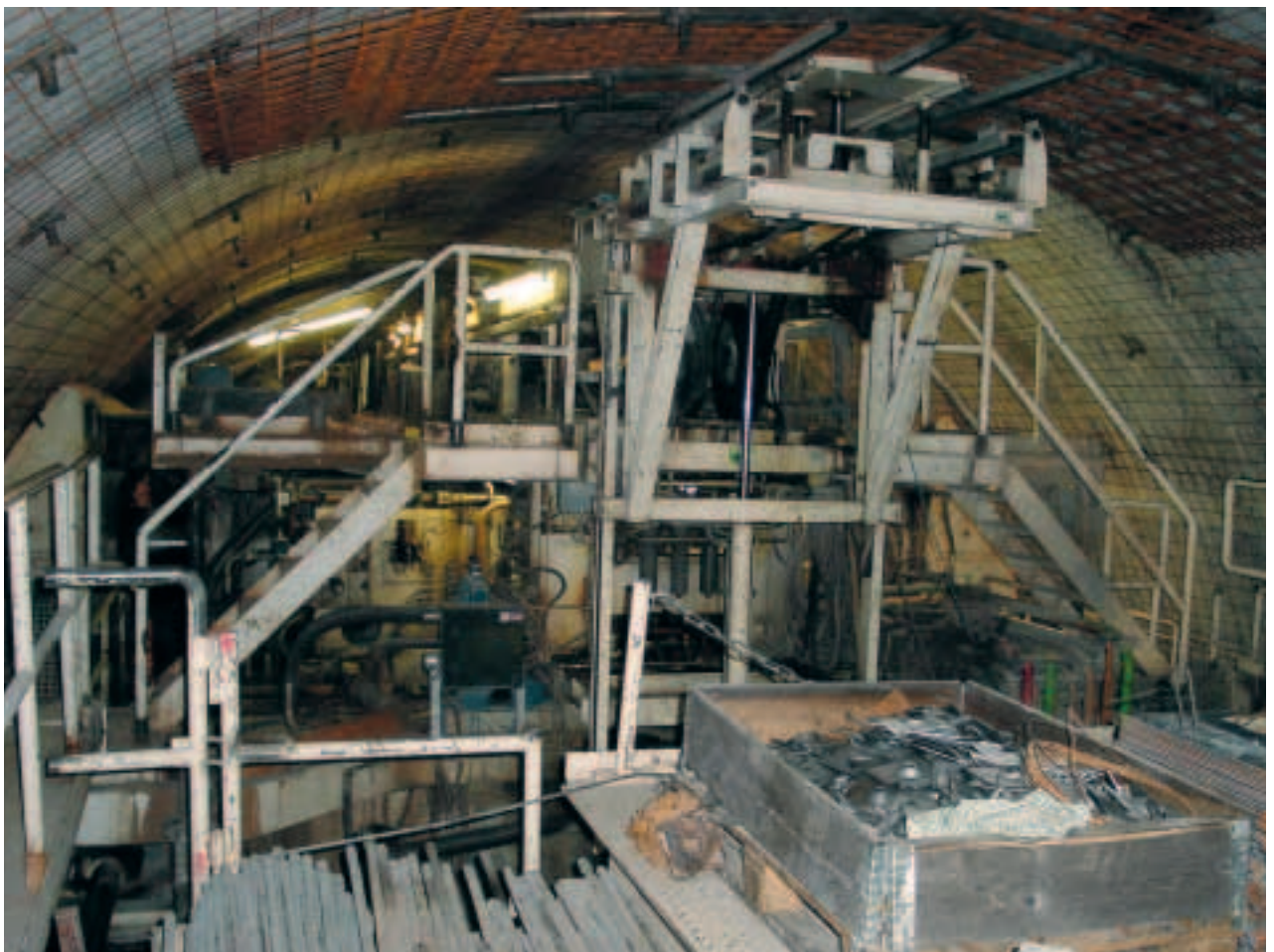
Abbildung 3 Verschalungsarbeiten im Stollen über der Tunnelbohrmaschine.
