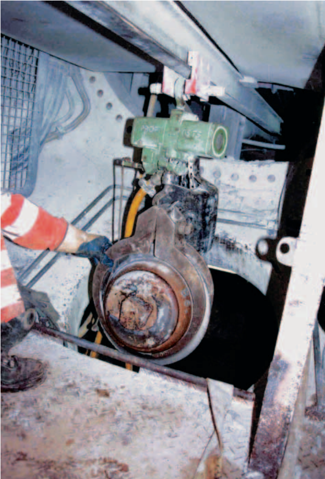
Figure 6 Remplacement des trépanes sur un tunnelier: une activité particulièrement exposée à la chaleur humide.
