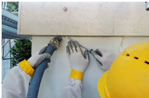
2 Rimozione con aspirazione alla fonte
