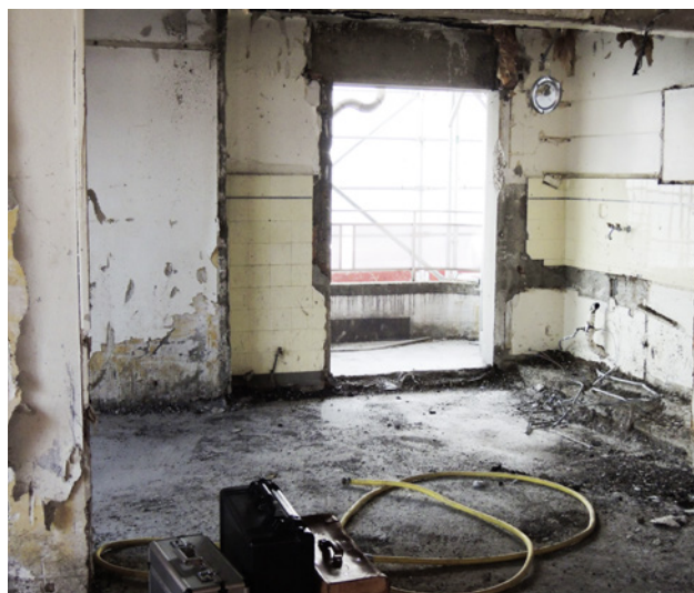
2 Déconstruction: bâtiment en démolition
