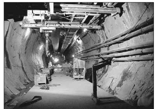
Bild 3: Einsatz eines Hängenachläufers, mit dem die Verkehrsströme entflechtet werden.
