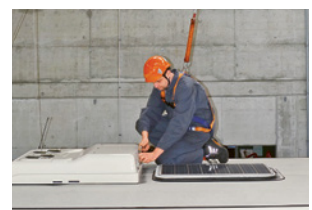
4 Absturzsicherung mit PSAgA auf Busdach
