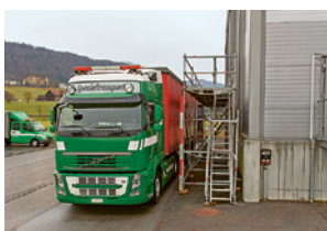
1 Gerüst für das Herunterstossen von Schnee und Eis
