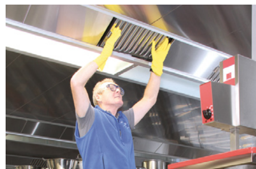
Bild 6: Reinigungsarbeiten mit entsprechender Schutzausrüstung vornehmen
