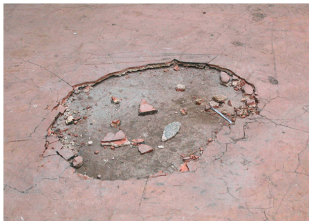
1 Pavimento in materiale composito a base di magnesite contenente amianto
