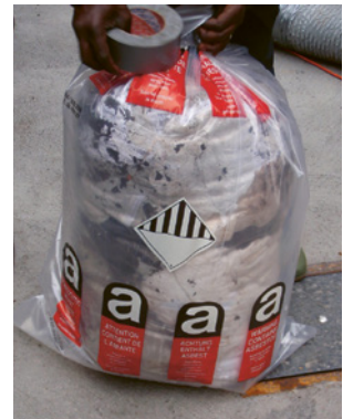
6 Sacco di plastica con la dicitura «Amianto»
