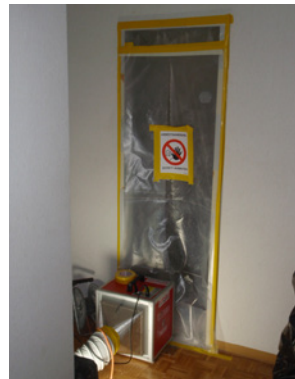
5 Zona da bonificare confinata con estrattore d'aria
