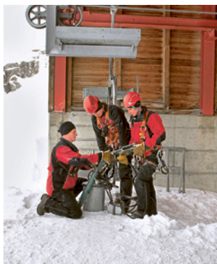
Regola 1 Pianificare con cura i lavori.
