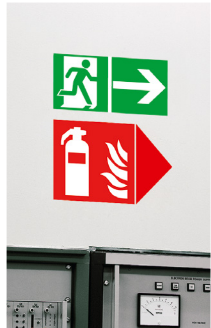
Bild 19 Kennzeichnung des Rettungswegs, kombiniert mit der Kennzeichnung des Wegs zum Material für die Brandbekämpfung
