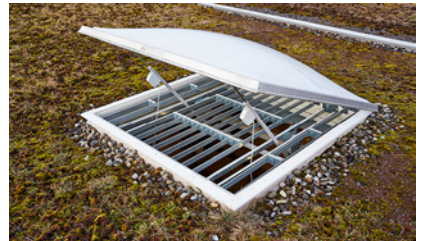
3 Dauerhaft gesichertes Oblicht mit innenanliegendem Gitter
