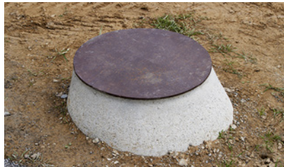
2 Rundschacht mit Eisendeckel abgedeckt
