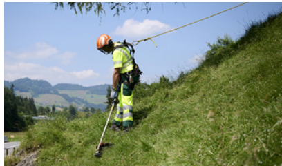
2 Arbeiten im steilen Gelände
