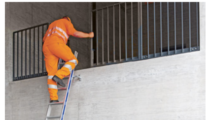
3 Haltevorrichtung, Seitenschutz und gesicherter Leiterkopf
