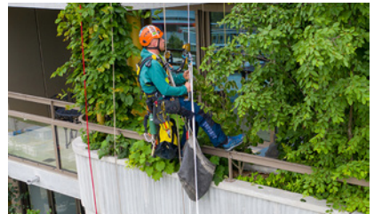
3 Arbeiten am hängenden Seil
