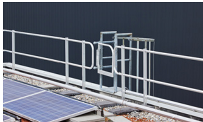
2 Seitenschutz Leiterausstieg
