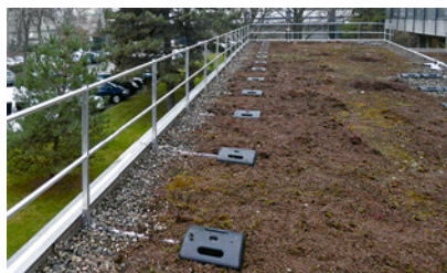
2 Dachrand mit Kollektivschutz
