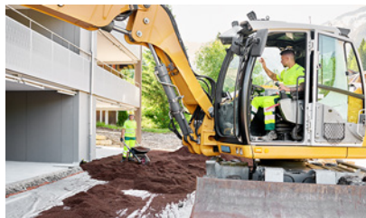
2 Gut sichtbarer Arbeitskollege im Gefahrenbereich einer Baumaschine
