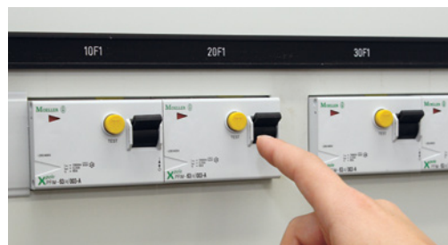
Fig. 20: les systèmes de protection contre les défaillances de courant sont impératifs en milieu humide et aqueux.
