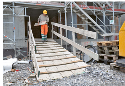
7 Accesso sicuro al cantiere grazie alle protezioni laterali e ai puntoni trasversali. Gli accessi al cantiere devono essere larghi come minimo 1 m.
