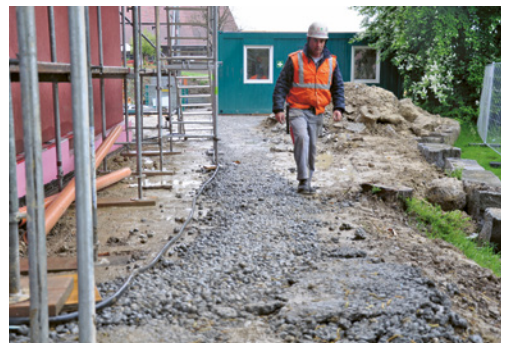
4 Dank des Magerbetons ist dieser temporäre Weg bei allen Wetterbedingungen sicher begehbar.
