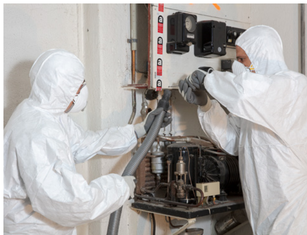
1 Während Arbeiten an asbesthaltigen Schaltgerätekombinationen werden die freigesetzten Fasern mit einem Asbeststaubsauger erfasst.
